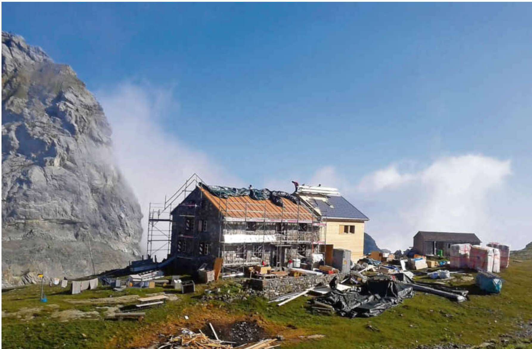
Happiger Arbeitsweg, spektakuläre Aussicht: Die Baustelle Claridenhütte auf 2453 Meter über Meer ist nicht alltäglich. Bild: zvg
